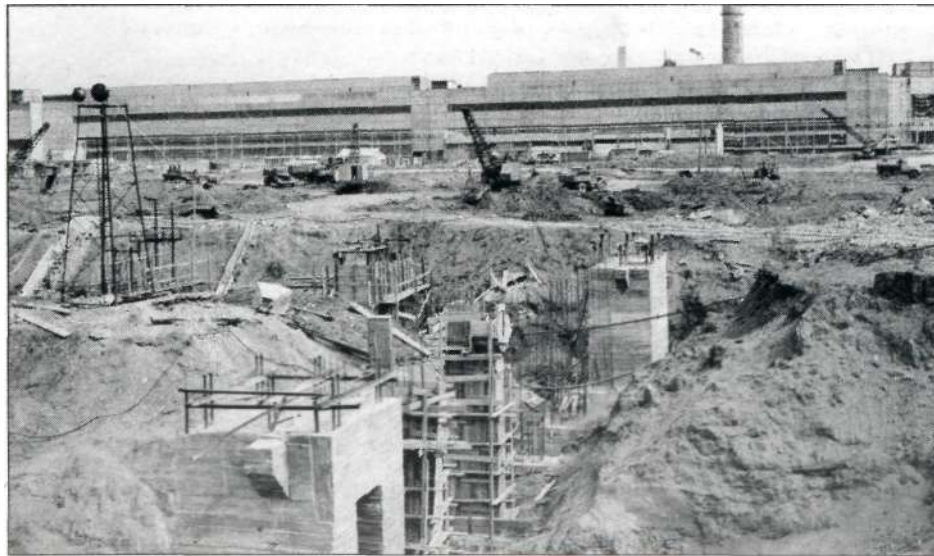
31 мая 1968 год. Панорама строительства стана холодной проката.
