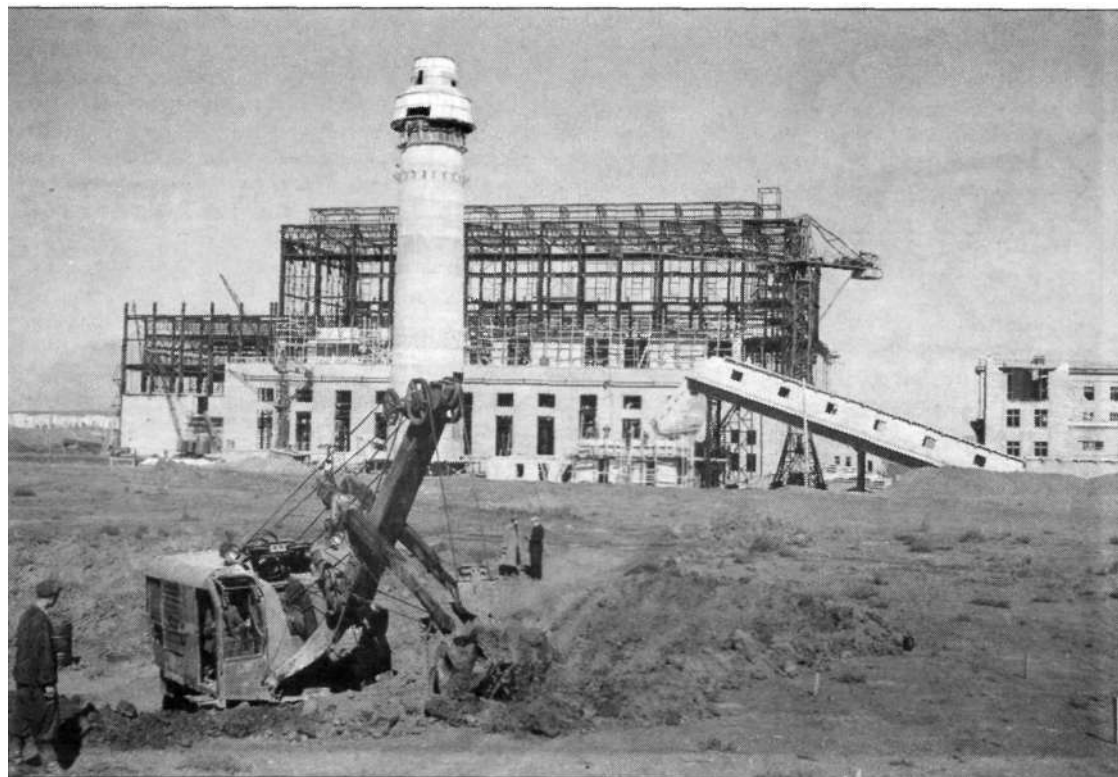
Экскаватор роет котлован под фундамент домны №1
