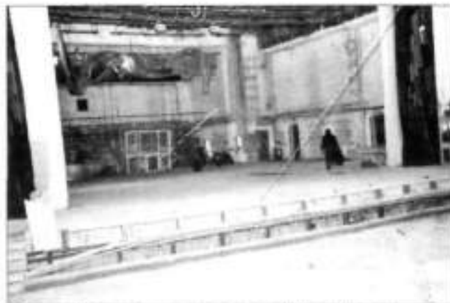
Строители собирают восстановительный металлокаркас крыши
