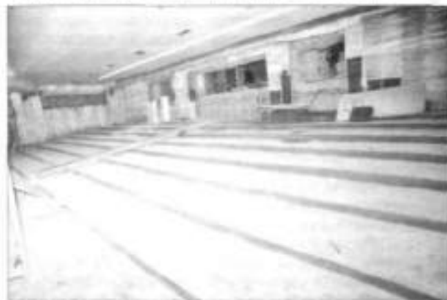
В зале демонтировали кресла, сейчас обшивку со стен
