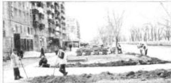
В работах участвуют 3 бригады: специальная бригада дорожников, бригады выкапывающих канавы и бордюры, бригады по асфальтированию тротуаров и газонов.
