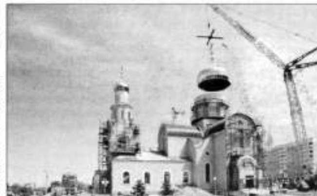
Опытные монтажники в автокрановых люльках сразу точно закрепили купол
