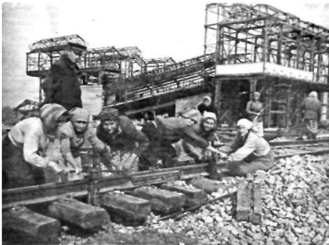
1959 год. Строительство доменной печи № 1 Фото предоставила Ирина Пансевич
